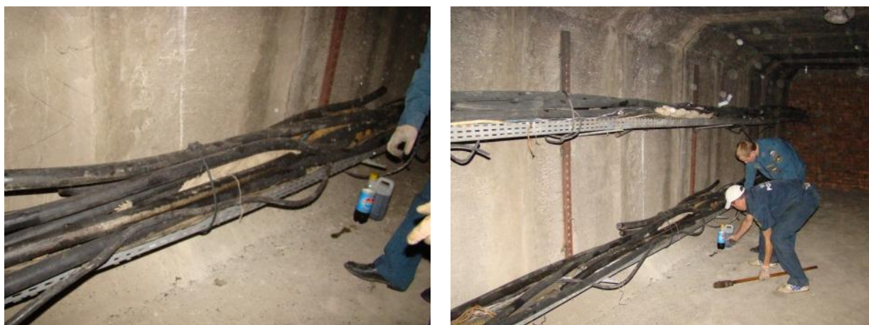
Рисунок 5.50 – Расположение горючей нагрузки в коллекторе
